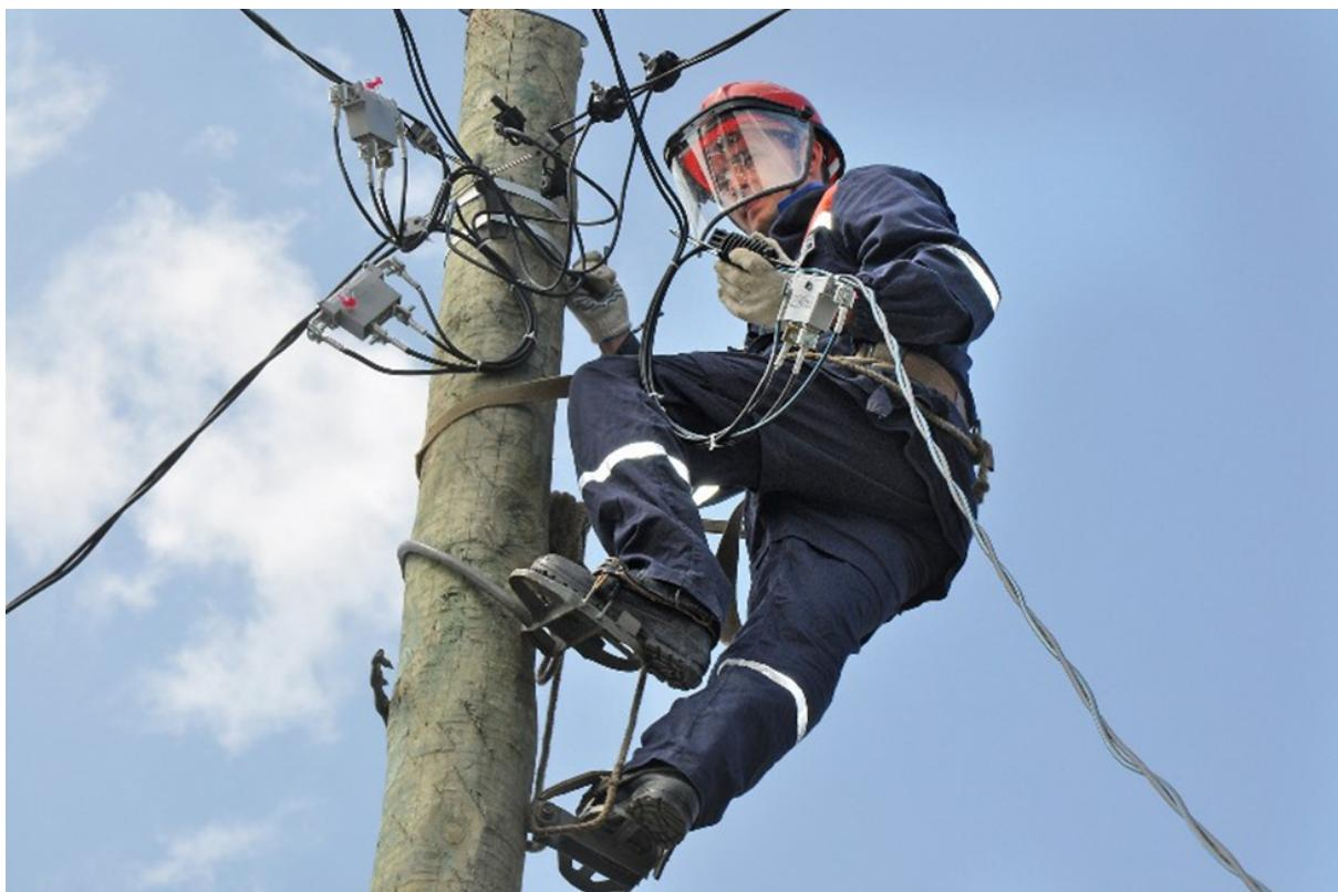
На данный момент в г. Новоульяновске смонтирована АСКУЭ «Матрица» на ТП-30, ТП-31, ТП-32 и ТП-58 и одновременно с этим произведена замена спуска – неизолированного отпаечного провода на СИП-4 от магистральной ВЛ-0,4 кВ до принимающего устройства потребителей бытового сектора.
